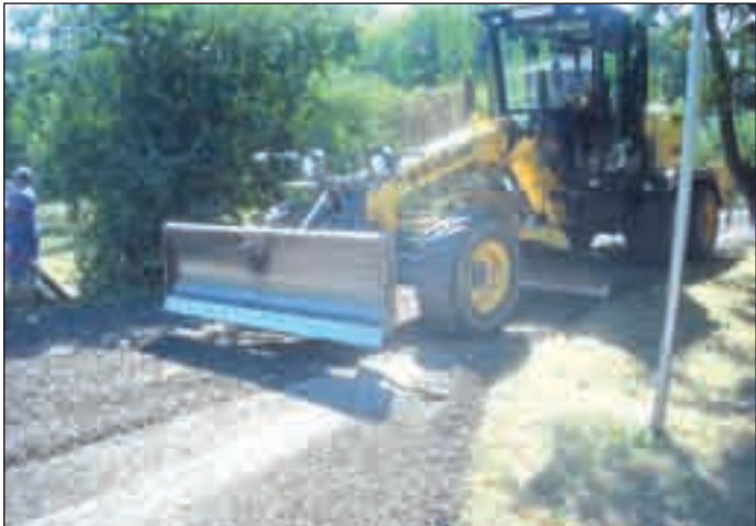
Úthelyreállítás mart aszfalttal - a szakemberek folyamatosan ellenőrzik a kivitelezést, hogy minden út jó minőségű legyen
