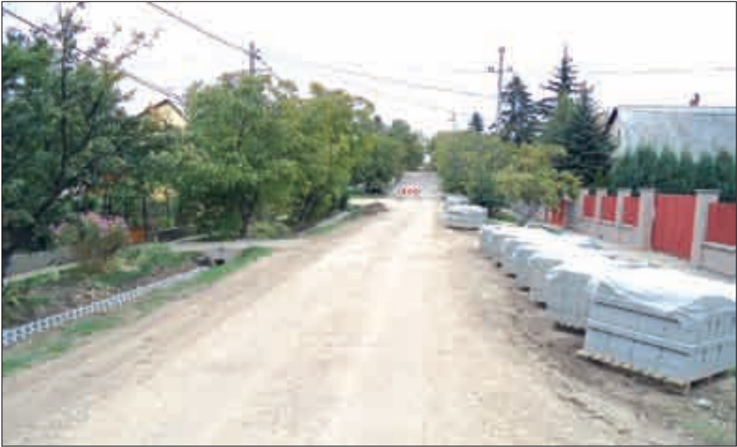
40 kilométerrel nőtt a pormentesített utak száma a csatornázás kezdete óta - képzünkön az aszfaltozás alatt álló Kossuth utca látható
