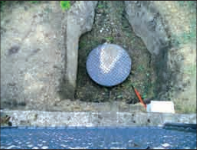
...és beépítés után – a tartály és a szerkezet a föld alá kerül
