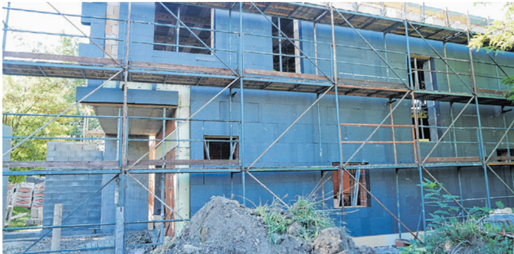
Gózeróval épül a Kincses Óvoda Fácán Tagóvodájának új épülete: az ötsoportos intézmény 436 millió forintból épülhet meg
