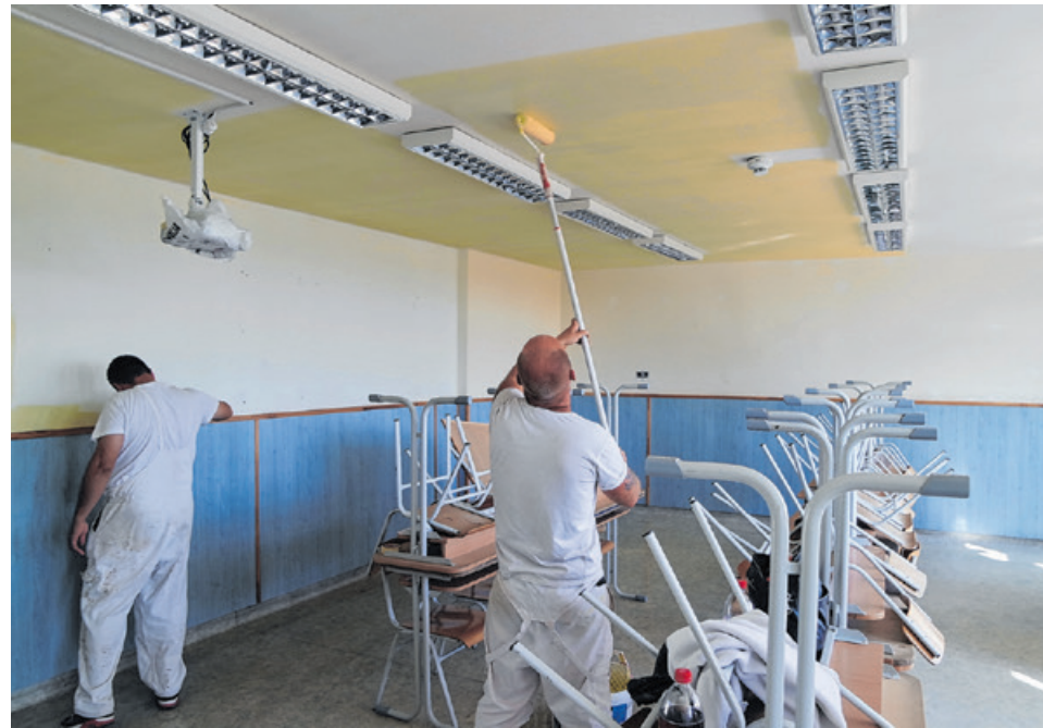
Az új tető már kész, jelenleg a belső munkálatok zajlanak
