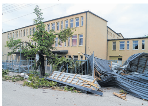
Az orkánerejű szél leszakította az épület lapostetejének mintegy harmadát
