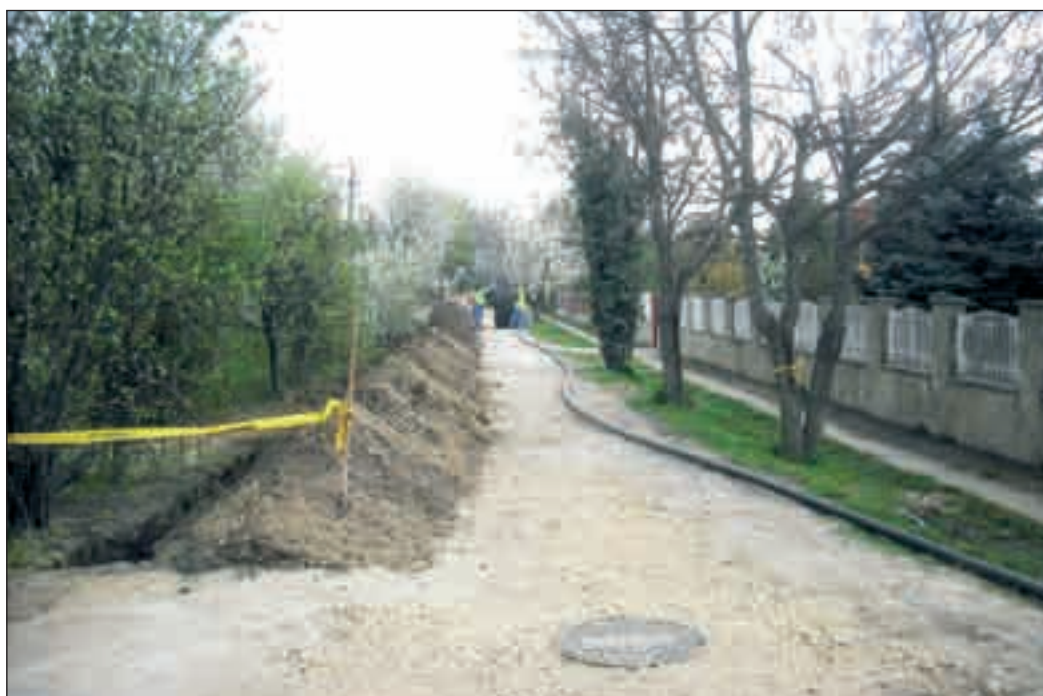
Fektetik a csatornát az egyik érdi utcában – a lakók hamarosan elkészíthetik a belső bekötéseket is
