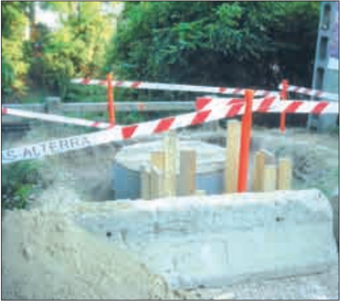
Folyamatosan zajlik a köztéri átemelők kiépítése is
