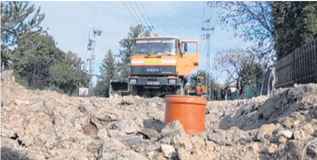
Útépítési munkálatok kezdődtek a csatornahálózat megvédése érdekében
