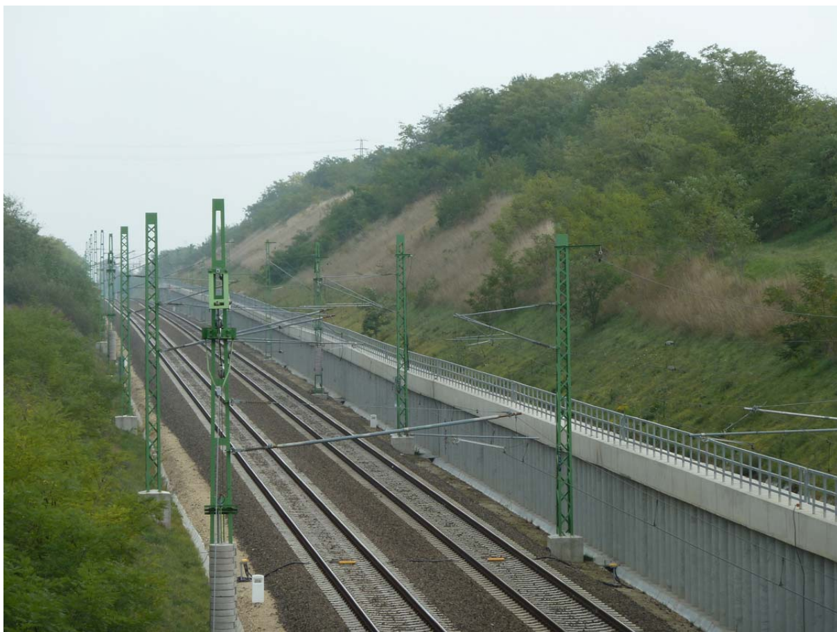
A 30a vasútvonal jelenlegi állapota Érd alsó irányába nézve
