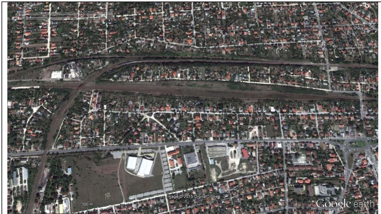
Tervezési terület a 30a vasút és a Velencei út között (2012)
