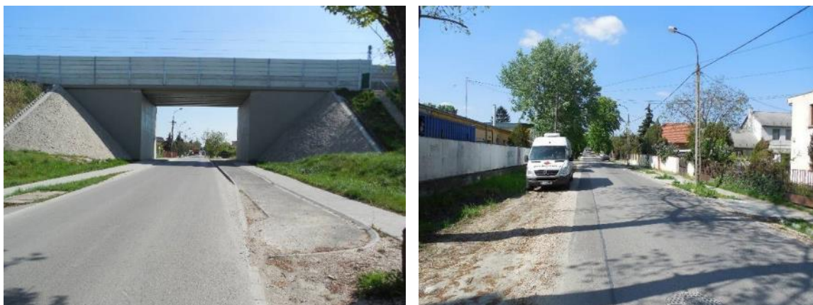
32. ábra – Duna utcai vasúti felüljáró alatt létrehozott felület. A kialakítás a belterületen kevésbé javasolható önálló kerékpárút átvezetésére készült, amelynek továbbvezetésére sem lenne hely.
