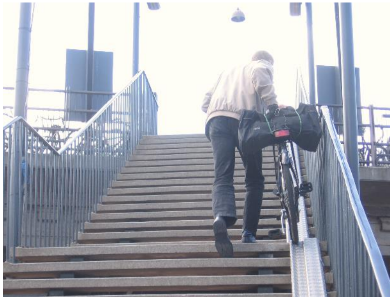
92. ábra Lépcső akadálymentesítésére utólag alkalmas ú.n. tolósín és jelölése
