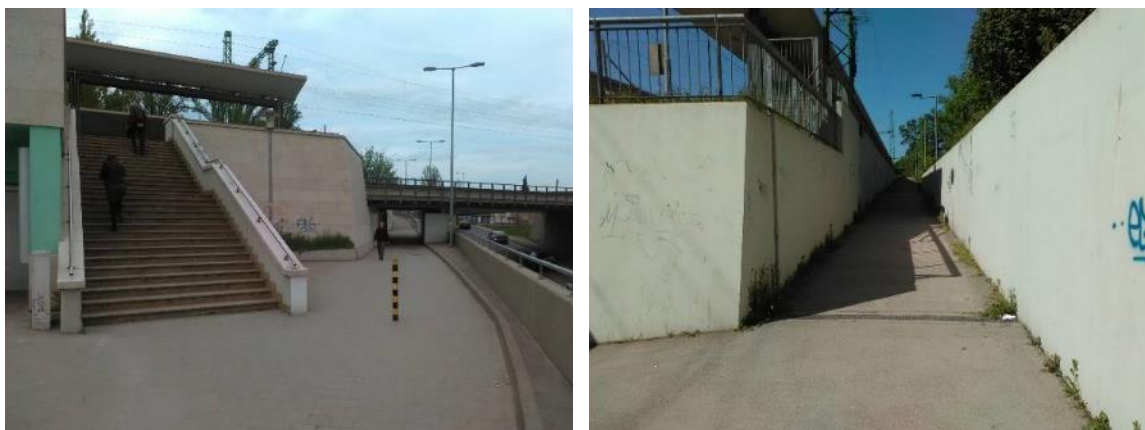
55. ábra – Érd felső Budapest felé ill. Pusztaszabolcs felé menő peronja
