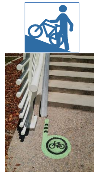
92. ábra Lépcső akadálymentesítésére utólag alkalmas ú.n. tolósín és jelölése
