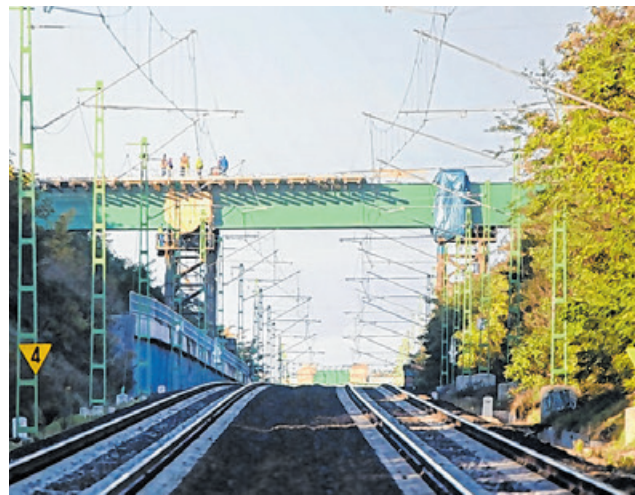
Mostanra már látszik, hogyan szeli át a híd a Rákóczi és az Előljáró utca közötti völgyeket
