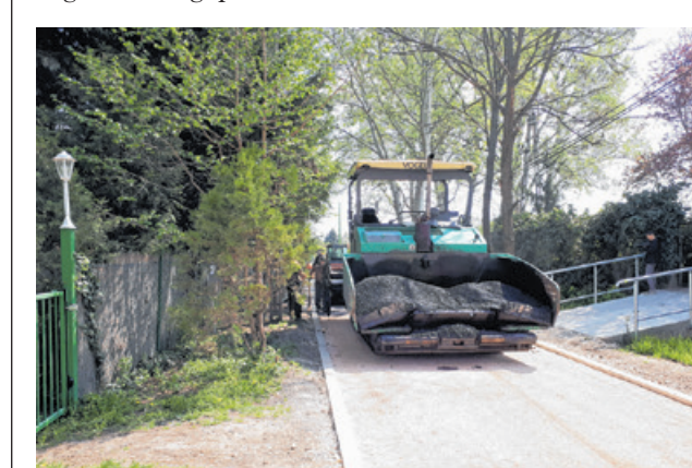
Nemcsak a vízvezetés, valamint a burkolat, hanem a kocsibedől is megújultak
