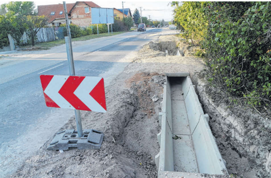
A Szovátai úton épül a csapadékvíz-elvezetés
