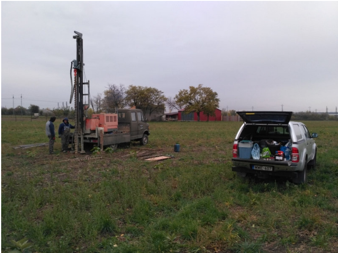
Érd-1 jelű talajfúrás mélyítése
