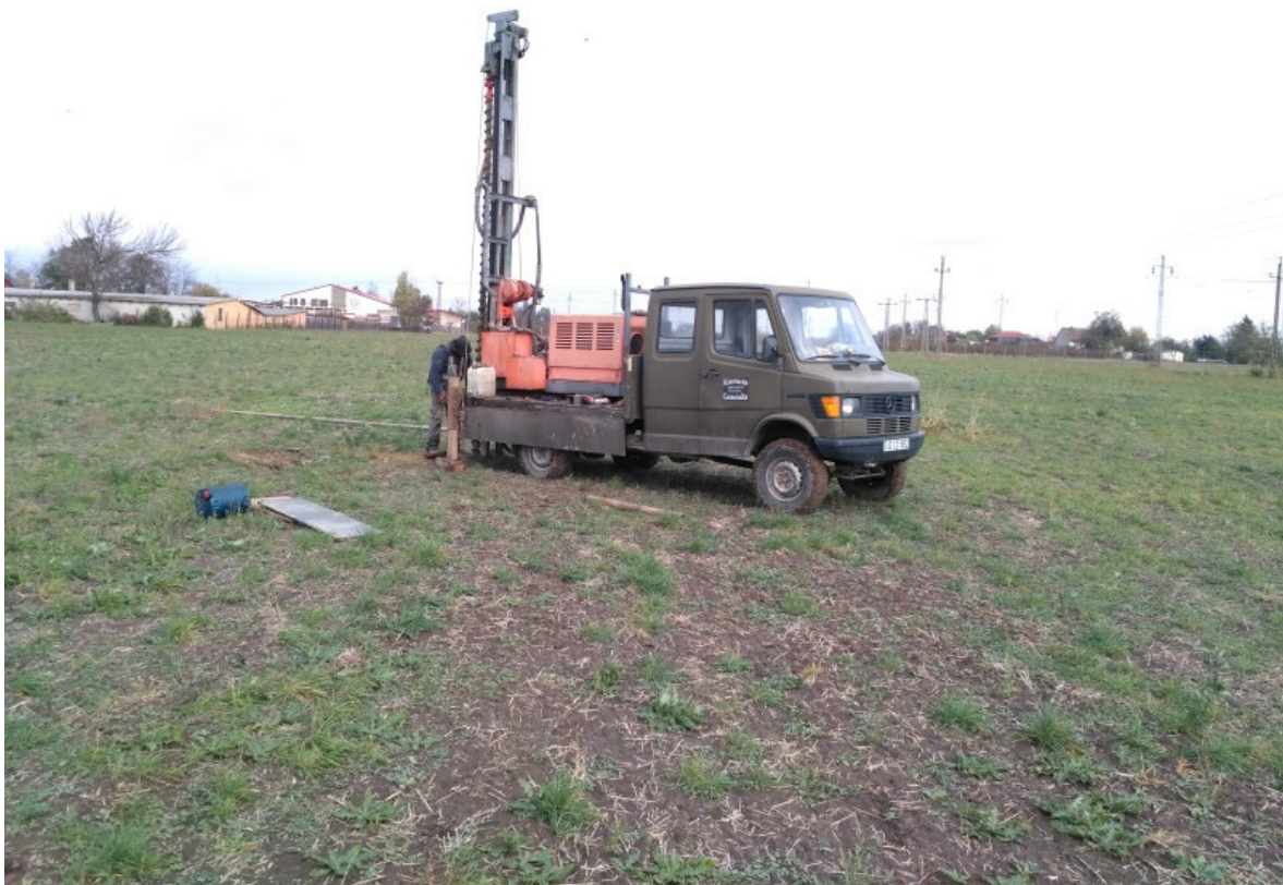
Érd-2 jelű talajfúrás mélyítése
