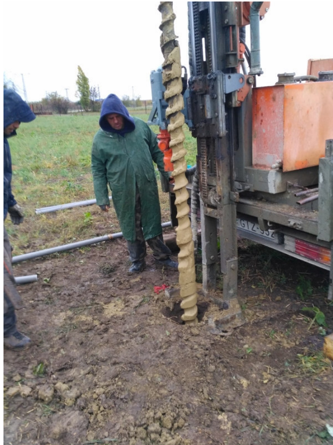
Fúrás végtelenített spirállal szárazon
