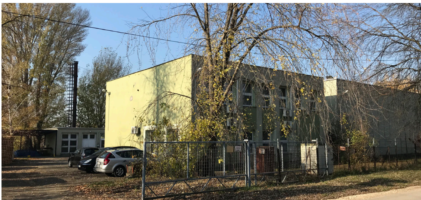
11.- 13. A tervezési terület északi telekhatára melletti területek: 099/2 hrsz-ú földút, gázfogadó és MÁV-Thermit Kft. irodaépülete
